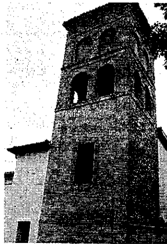
La torre restaurata
