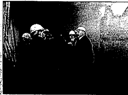
CANTIERE Un momento della visita dei giornalisti per fare il punto sui lavori in corso.
