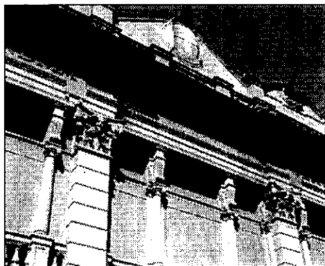
FACCIATA STORICA L'esterno dell'ex cinema Metropol, che ospiterà aule giudiziarie per svolgere dibattimenti
