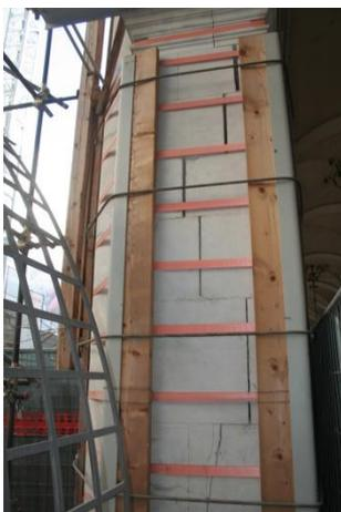
Figura 20. Foto di un pilastro soggetto a dislocazione delle lastre di rivestimento.
